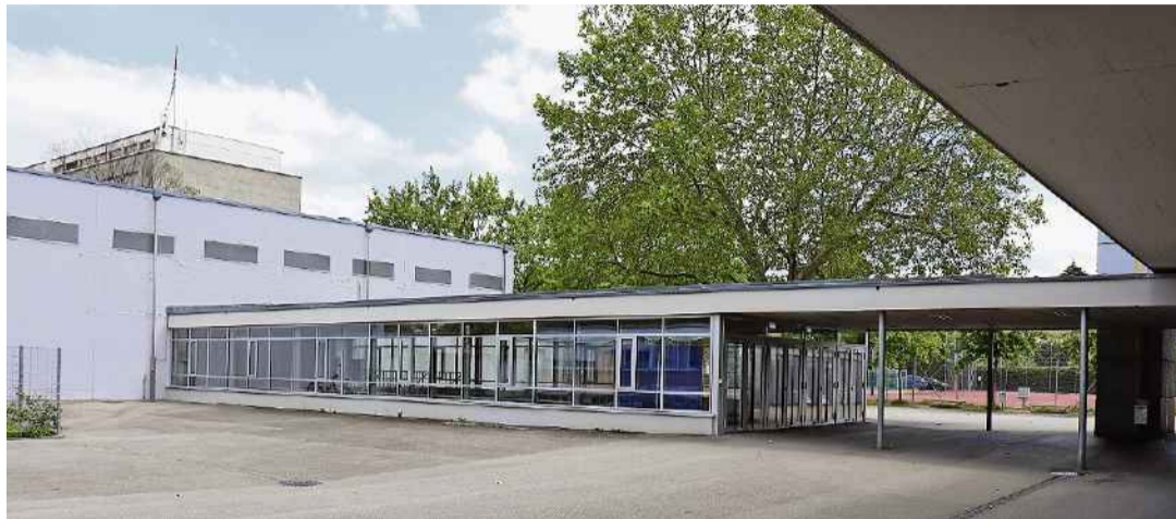
Das Dach der Turnhalle der Bezirksschule ist undicht. Bisher wurde nur zweckmässig geflickt. Bild: cla
